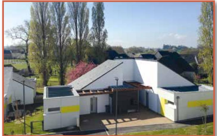
Les travaux de rénovation ont consisté en la mise à nu du gros oeuvre (dépollution désamiantage), réfection complète des couvertures, doublage, menuiseries extérieures et volets roulants, cloisons, électricité, sanitaires, chauffage, VMC, peinture et sols souples.
